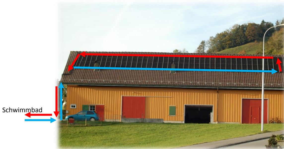
Das kalte Wasser wird mittels Pumpe, aus dem Schwimmbad auf das Dach gepumpt. Es gelangt durch 19 Schläuche, die einen Durchmesser von 25mm haben auf die rechte Seite des Daches. Danach fließt das Wasser hoch und nochmals durch 19 Schläuche auf die linke Seite und dies 2mal und von dort an runter in das Schwimmbad. Durch die Sonneneinstrahlung, werden die schwarzen Schläuche erhitzt und das Schwimmbad somit geheizt.
