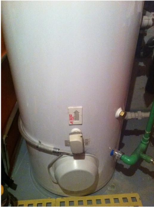
Zum Entkalken muss man den Deckel entfernen und den Dichtungsring ersetzen. Dann sieht man den Kalk, aber man sollte es immer von einem Fachmann machen lassen.
