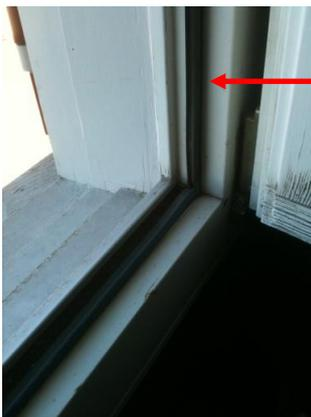
Dichtung-Innenfenster: Die **NBR-Dichtung** wurde einfach angeklebt, so ist es einfach die Dichtung zu entfernen. Man kann deutlich die Risse sehen die mit der Zeit entstanden sind.
