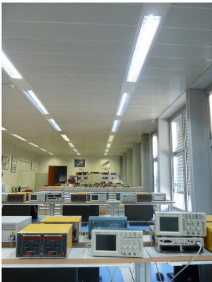
*Sur l'image de gauche, au fond, la salle est équipée de néons standards. Devant sont installés les tubes LEDs. Ces tubes sont d'un blanc « industriel », très froid (6000° K). Les tubes néons, eux, sont plus chauds (3500° K).*
