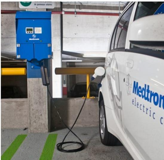
Cette borne permet le rechargement d'une voiture entre 1h30 et 8h00. Elle permet aussi de recharger 2 vehicule simultanément. La borne est réglementée il faut une carte pour l'utiliser elle permet aussi d'être gérée en réseau ce qui fait d'elle une borne très pratique par les parking.
