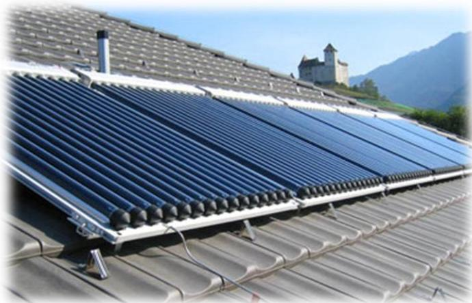
Abb. 9 Vakuumröhrenkollektor
