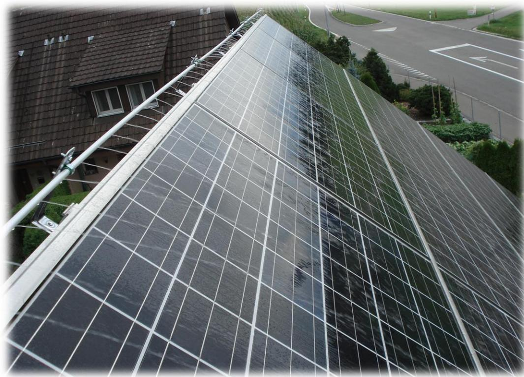
Abb. 15 Eingeschaltete Photovoltaikanlagekühlung
