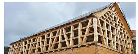
Bild 1 Riegelbau<sup>2</sup>
