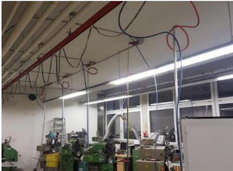
Abbildung 3: Neue Pneumatikleitungen
