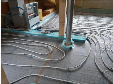
Abbildung 13 Einbau Bodenheizung
